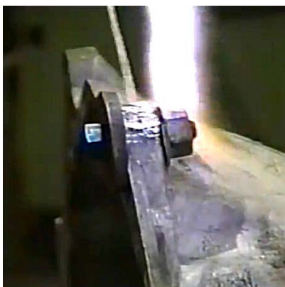
Закрепляем болт с двух сторон и наращиваем недостающую часть детали между шайбами
